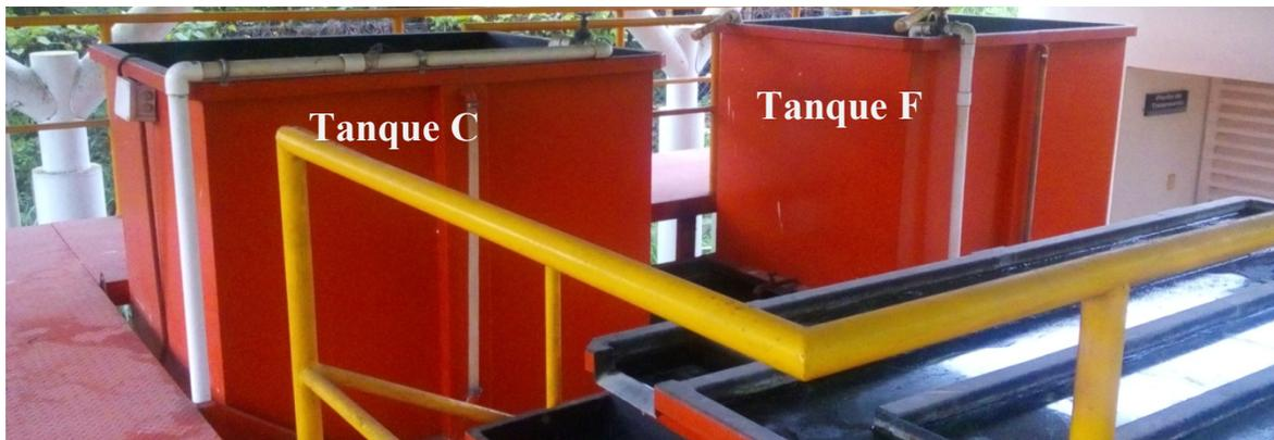
FIGURA 8 TANQUE DE ÓXIDO DE CALCIO (TANQUE C) Y TANQUE DE SULFATO DE ALUMINIO (TANQUE F)
