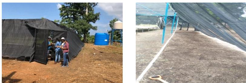
**Figura 3.** Colocación de mallas media sombra en la parte superior como laterales
